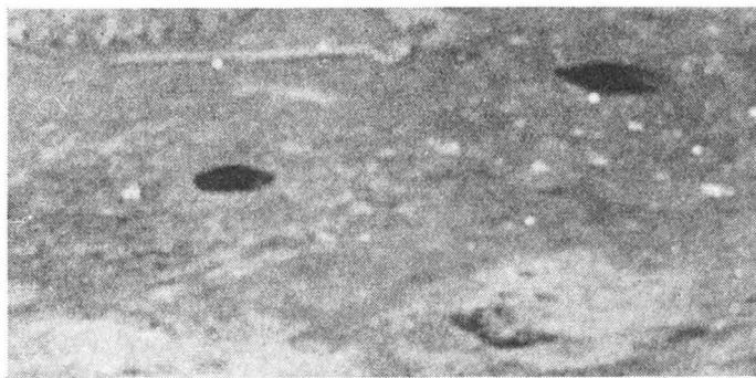
Välikanteen poltettuja sammutusreikiä.
