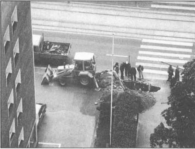
Kaasuviivon katkaisun toinen vaihe on käynnissä putken Hämeentien puoleisessa päässä. Energialaitoksen (Kaasulaitos) korjausmiehistö on pääsemässä käsiksi maanalaiseen kaasujohtoon. Kun putki oli saatu tukittua myös tästä päästä oli välitön vaara saatu torjutuksi.
