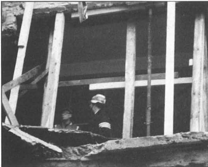
Päivystävä palomestari ja rakennusviraston edustaja tarkastamassa vahvasti tuettuja sortumavaaran alaisia rakenteita. Tukirakenteiden yläpuolella oleva tiilirakenteinen hormisto oli eräs uhkaavimmista kohdista. Se tuettiin myös vaakasuorassa suunnassa vyöttämällä vaijereilla.
