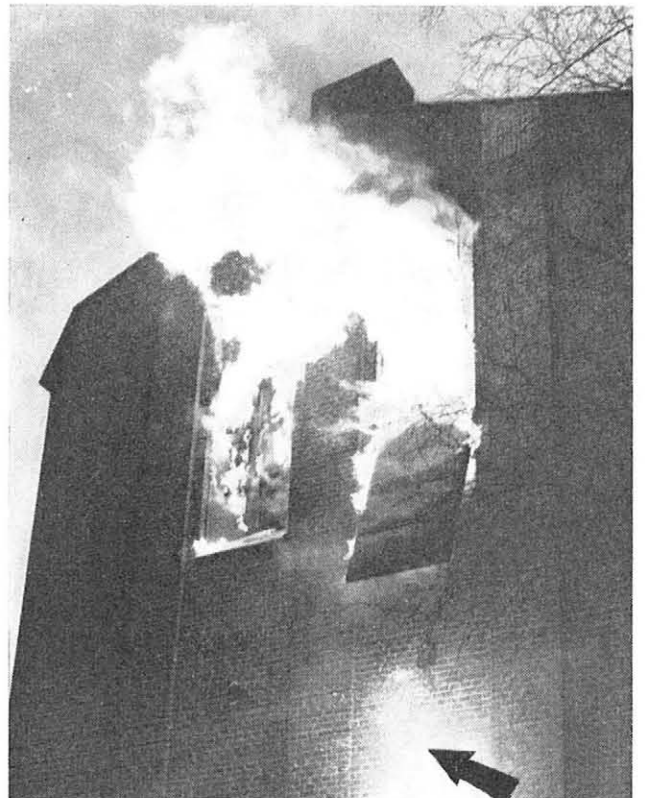
KUVA 5. Näyttämön savunpoistoluukuista vain toinen on osittain auennut palokaasujen paineen vaikutuksesta. Toisesta lyövät liekit jo osittain läpi. Luukut oli rakennettu ulkopuolelta vaijereiden avulla avattaviksi, mutta suunniteltua avausta ei kuitenkaan voitu suorittaa suurjännitteisen säbböjohdon estäessä sen. Laukaisuvaijereiden kiepit näkyvät savunpoistoluukkujen alapuolella. Nuolella osoitetussa kohdassa voimakasta kipinöintiä linjassa.
