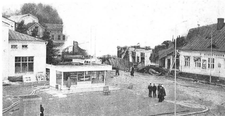
5 PORTTI Riistakadun puolella on nyt avoin. Kuvan keskellä olevan porttipylvään takana on räjähdyspaikka. Pylvään kohdalla taustalla näkyvä savustunut tiiliseinä on naapuritontilla merkinä palonkestävästä palomuurista. Ja kuvan oikeassa reunassa nähdään täysin tubuotuneen kivisen V2:n kulma.
