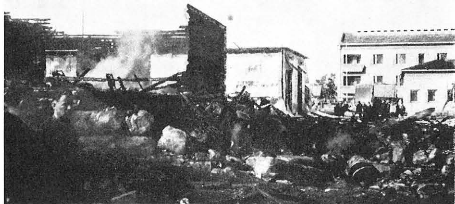
4 PIHANÄKYMÄSSÄ rakennuksen A2 raunioiden päältä katsottuna on räjähdyspaikka albaalla oikealla kivikasan edessä. Taustalla nähdään peltiseinäinen rakennustarvikevarasto V7, jonka seinäpinnat aaltoilevat rakennuksen runkoa vasten räjähdyspaineen muotoilemana. V7:n edessä seisova mustunut seinä on varastorakennuksen V5 pääty.
