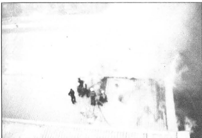
Katto on saatu avattua syttymispaikan yläpuolelta. Syttymispaikka näkyy pohjapiirroksessa 9. ja 10. "hampaan" välissä. Kuvan tilanne on noin klo 22.50 aikaan.
