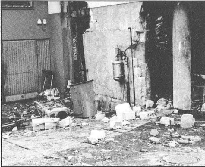
Keskellä höyrystäjä ja maassa sen suojakotelo. Maanalaisen pallosäiliön tilan kansi oikeassa alanurkassa. Katso myös kansikuvaa.
