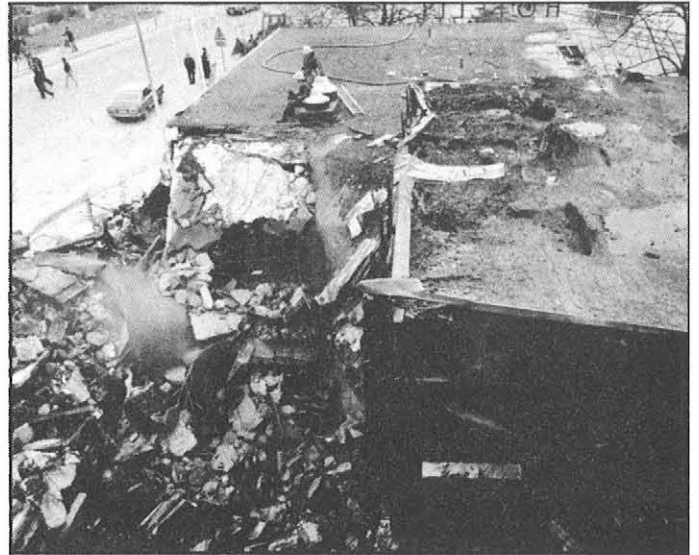
Räjähdyksen aiheuttamia sortumia hotellin Siltakadun puoleisessa osassa.
