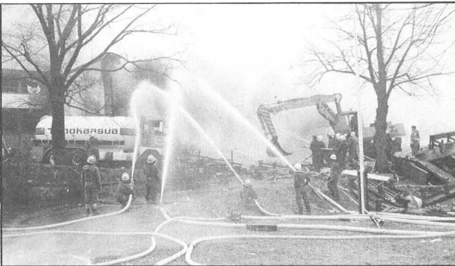
On päästy käsiksi säiliöauton siirtoon pois täyttöpaikalta. Voimakkaat suihkut jäähdyttävät autoa ja sammuttavat samalla takana palavaa hotellia.
