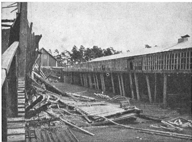
Kuva 4. Vasemmalla palaneita puusepäntehtaan rakenteita, oikealla sahan lajittelurakennuksen rakenteita. Etäisyys n. 11 m. Palon alkuvaiheessa sortunut osa puusepäntehtaan päätyseinästä näkyy kuvan keskellä. Huom. lankkusilta puusepäntehtaan ja lajittelurakennuksen välissä.
