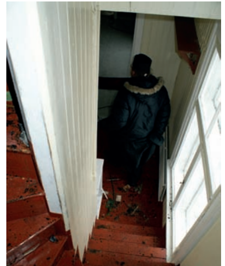
1840-luvulta peräisin olevan puurakennuksen portaikot ovat kuiluja, joiden kautta isojen kalusteiden evakuoiminen oli vaikeaa.
