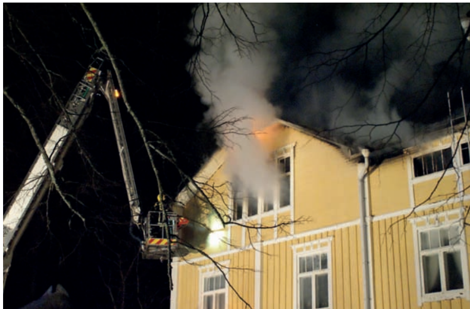
Ennen konesaumatus peltikaton purkukaluston paikalle tuloa luostaripaloa rajoitettiin Joensuusta ja Varkaudesta tulleiden nostolava-autojen avulla.
