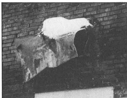
Paperitehtaan ja varaston välistä osastoivaa seinää vahdittiin tarkoin. Seinästä poistettiin ilmakehän putki ja aukko tukittiin lasivillalla. Vasemmalla aukko palaneen hylsyvaraston puolelta ja oikealla paperitehtaan puolelta.
