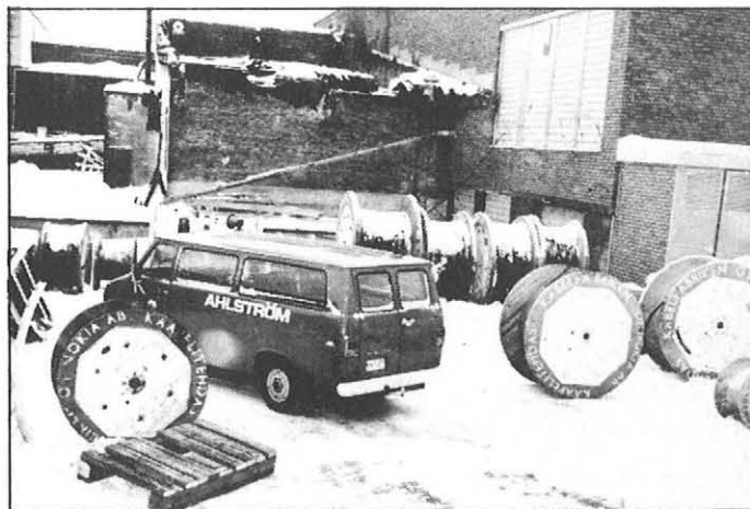
Palossa tuhoutunut varasto oli rakennettu kohtisuoraan paperitehtaan kiinni. Osastoivassa seinässä oli palo-ovia ja -luukkuja. Hylsyjen käsittely ja kuivaus tapahtui erillisessä palo-osastossa (etualalla kuvassa). Tämä osasto tuhoutui, samoin keskusvaraston kattorakenteet, mutta muu osa keskusvarastosta säilyi.
