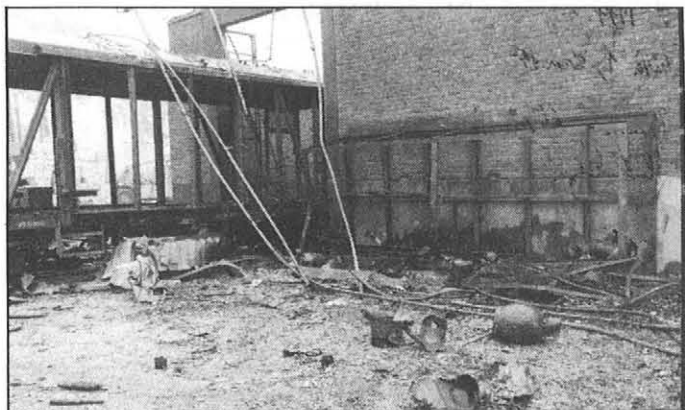
Revenneitä ja pullistuneita nestekaasupulloja palon jäljiltä. Nestekaasupulloja tuhoutui yli 60 kpl. Puisen lastauskatoksen mukana sortuivat sprinkleriputkistot varaston päädyssä. Täällä paloi myös 5 rautatievaunua.
