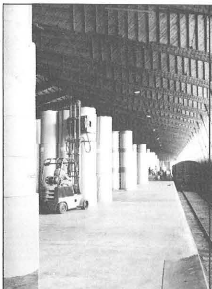
Sisäkuva tuhoutuneen varaston uudelta puolelta. Huom! pinoamiskorkeus ja HB-kehät.
