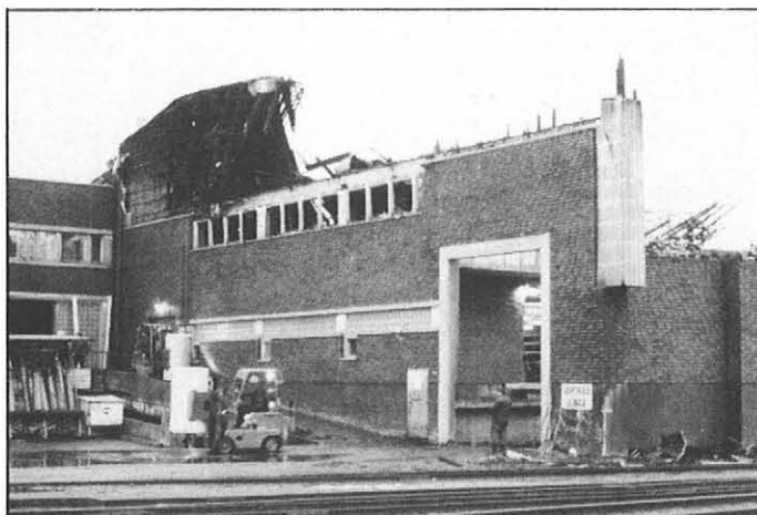
Paperivaraston katon alla tehtaan puoleisessa päässä oli kolmikerroksinen keskusvarasto, joka toimi "puskurina" kohti paperitehdasta voimakkaasti tunkanutta tulta vastaan. — Kuvan vasemmalla reunassa hitsauskaasupulloja, jotka palon aikana, evakuoitiin.
