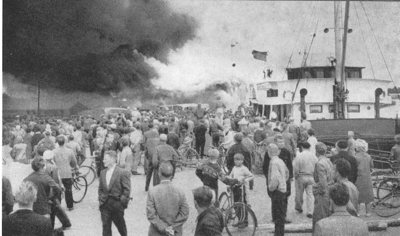
Satamavarasto paloi Kotkan satamassa 30. 6. 1959. Palo sammutettiin kahdessa tunnissa, mutta vartiointi ja jälkiraivaus kesti parisen viikkoa. Palo syttyi rakennustyömaan kompressorin sähkölaitteista klo 17.26. Palovahingot olivat 48 milj umk + 16 milj umk kuljetusvahinkoina. Laivat ja nosturit pelastettiin. 300 tonnia sulfaattiselluloosaa ja 340 tonnia paperirullia paloi. Lisäksi tuhoutui 400 m rautatiekiskotusta, 10 rautatievaunua, erilaisia koneita ja muuta sekalaista omaisuutta.
