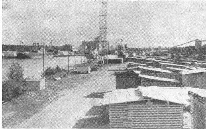
Toppilan satama alajuoksun puolelta.
