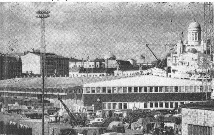
Toinen turvallista rakennustapaa edustava kuvamme on Eteläsatamasta.
