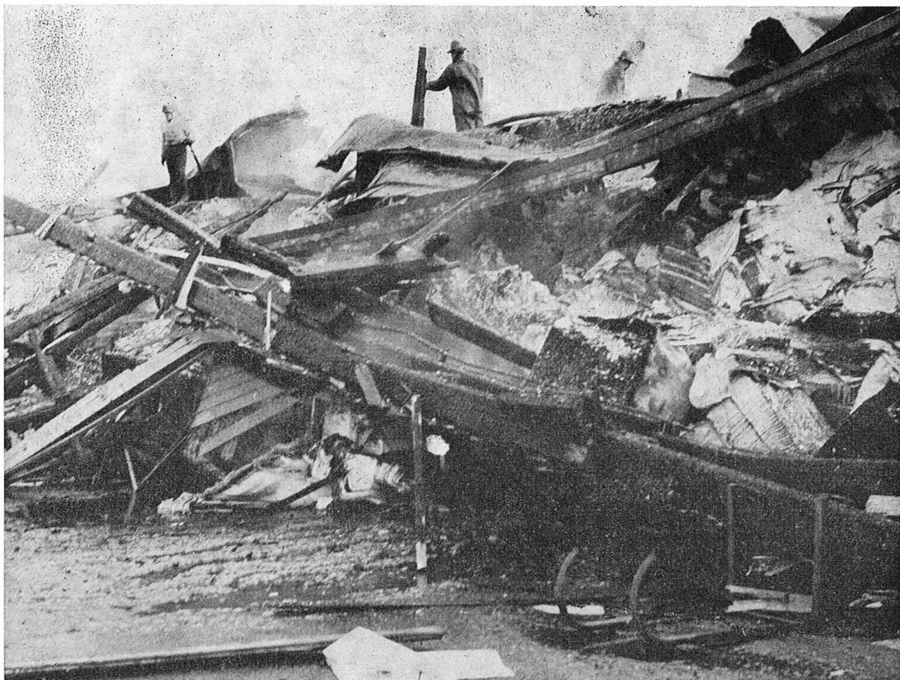
Sammutusmiehistö etsii palopesäkkeitä paaliröykkiön päällä.
