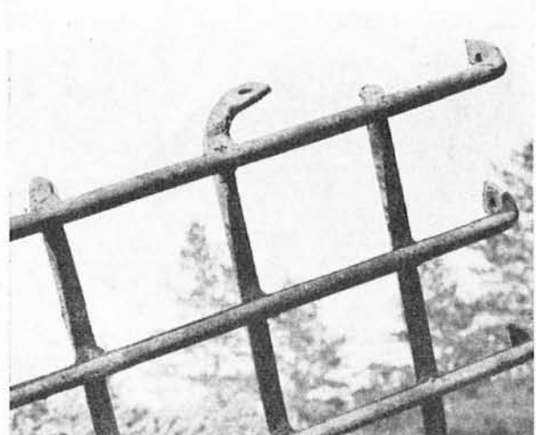
Miesten eristyshuoneiden ikkunoiden kalterirakennetta.
