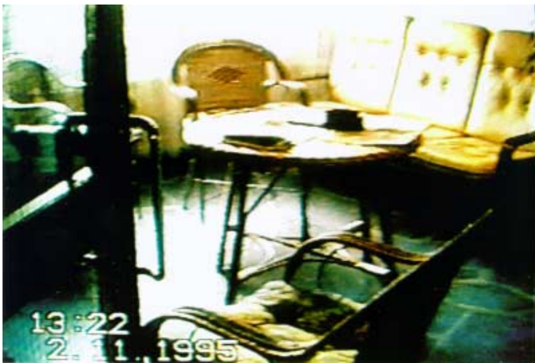
2.11.1995 kuvatulta videonauhalla otettu valokuva sisääntuloaulan takkahuoneesta kuvattuna vanhan majoitusosan käytävään johtavalta palo-ovelta, joka erottuu auki-asennossa kuvan vasemmassa reunassa.
