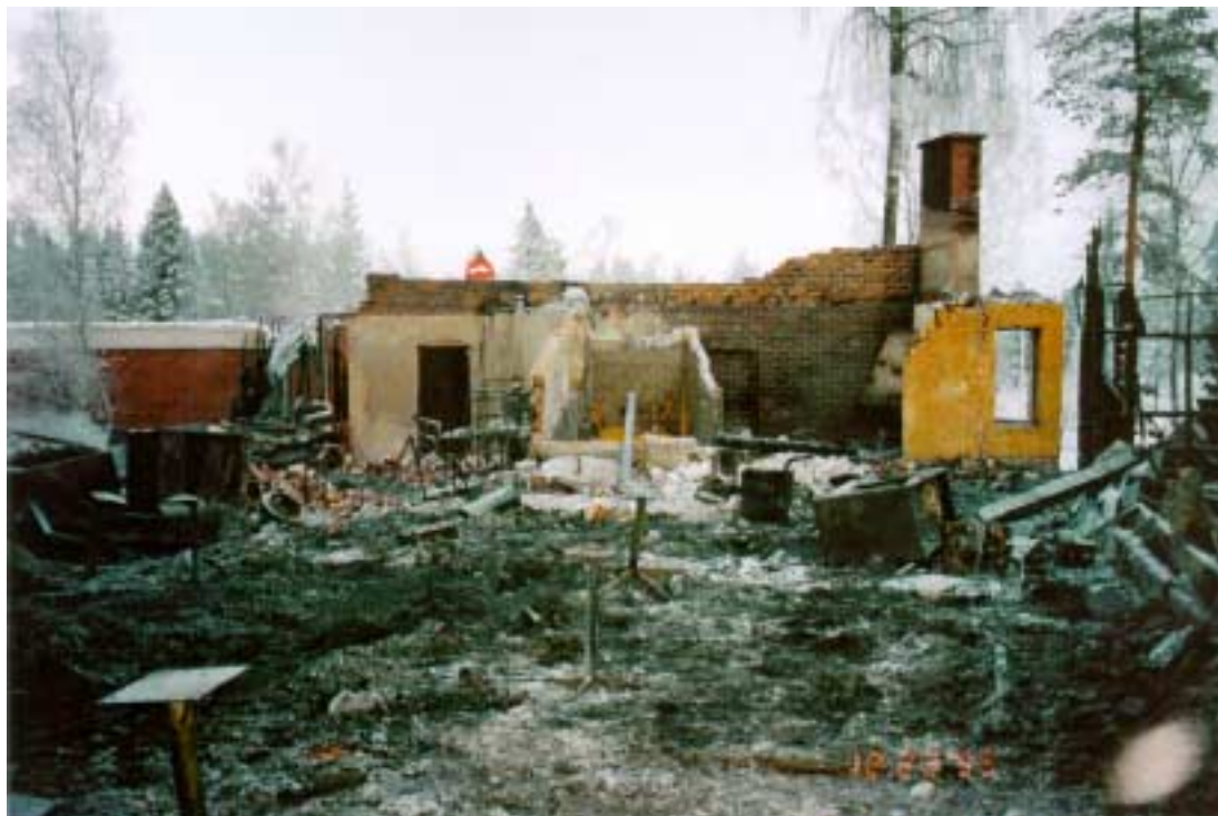
Tuhoutunut ravintola kuvattuna salin suunnasta sisääntuloaulan suuntaan, joka on sijainnut keltaisen tiiliseinän kohdalla.
