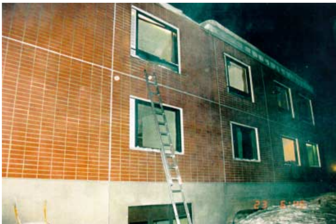
Uuden majoitusosan järven puoleinen sivu (länsisivu) 23.12.1995 klo 06.46. Tikkaat ovat nojallaan kellariin johtavassa ajoluiskassa yläkerran kulmahuoneen (huone 20) kohdalla.
