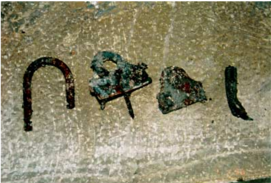
Tutkinnan aikana löydettiin ja taltiointiin sisääntuloaulan ja ravintolan välisen paljeoven riippulukon ja sen kiinnikkeiden jäännökset sellaisesta kohdasta, joka osoittaa paljeoven olleen kiinni palon aikana,
