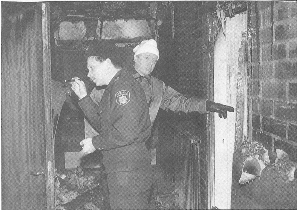
Tutkintalautakunta tutkimassa palon jälkiä vanhan osan hotellikäytävällä, josta palo takana hämmöttävästä, silloin avoimesta palo-ovesta levisi uudelle puolelle.
