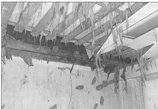
Eräs keskeisistä tutkimuskohteista on hotellihuoneiden rakenne. Väli-pohjan eristeet kehittivät voimakkaan savunmuodostuksen. Se vaikeutti pelastautumista ja aiheutti hätäännystä hotelliasukkaiden keskuudessa.
