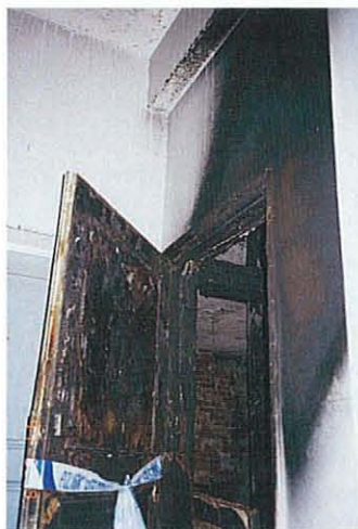
Palohuoneiston ovi rappukäytävään.
