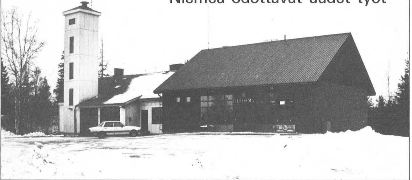
Luvian paloaseman laajennus valmistui viime keväänä. Uuteen punatiiliseen lisäsiipeen sopii hyvin kaksi paloautoa ja piakkoin saatava öljyntorjuntavene. Alakerrassa on tilaa noin 150 neliötä. Vanha vaaleampi osa palvelee nykyisin korjaushallina.
