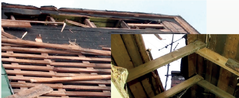
Lopputuloks yhdellä vedolla. Tästä on helppo laajentaa savunpoistoaukkoa.
