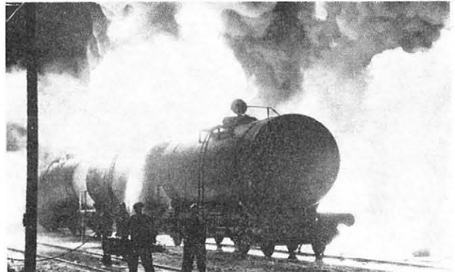
KUVA 4. Vaunu n:o 7, josta kuumentamisen johdosta bensiini purkautui kansiluukun raoista ja varoventtiilistä, palaen komeana suihkuna ja valumisellaan pitäen paloa vaunun rakenteissa.
