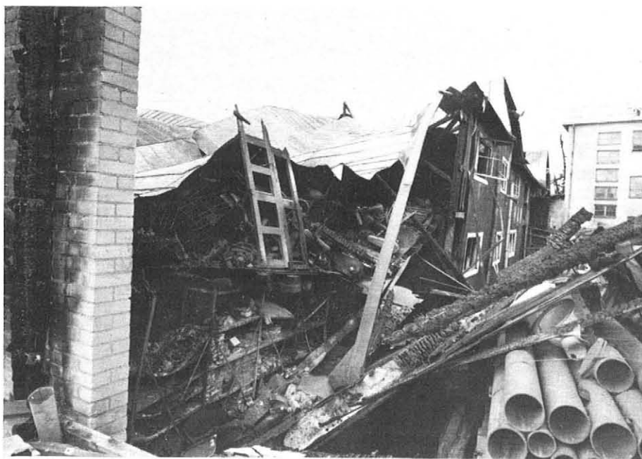
Omaisuuuden ylivoimaisesti kallisarvoisin osa oli varastoitu paloteknisesti heikoimpana pidettävään rakennukseen 4. — Laajamittaisista jäännösarvojen suojele- ja kunnostustoimenpiteistä erillinen kirjoitus tulevassa Palontorjuntatekniikka-lehden numerossa 1974:1.
