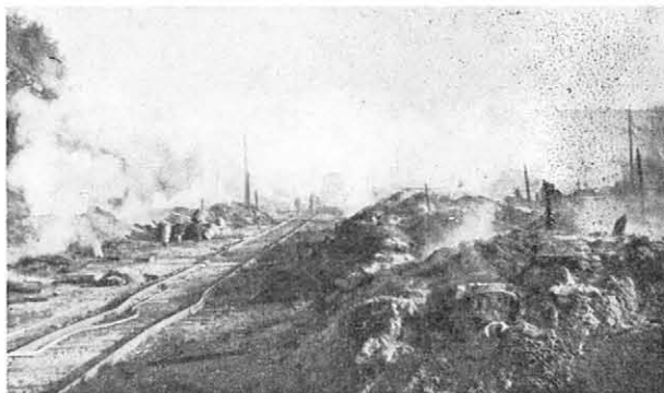
Palopaikka seuraavana aamuna. Huom. kuumuudessa vääntyneet kiskot.
