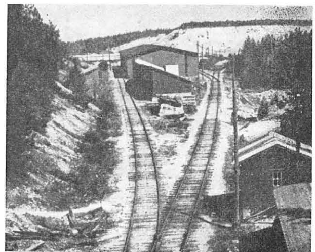
Yli 100 m pituinen puinen viljavarastorakennus (keskellä) ennen tuhoutumistaan.
